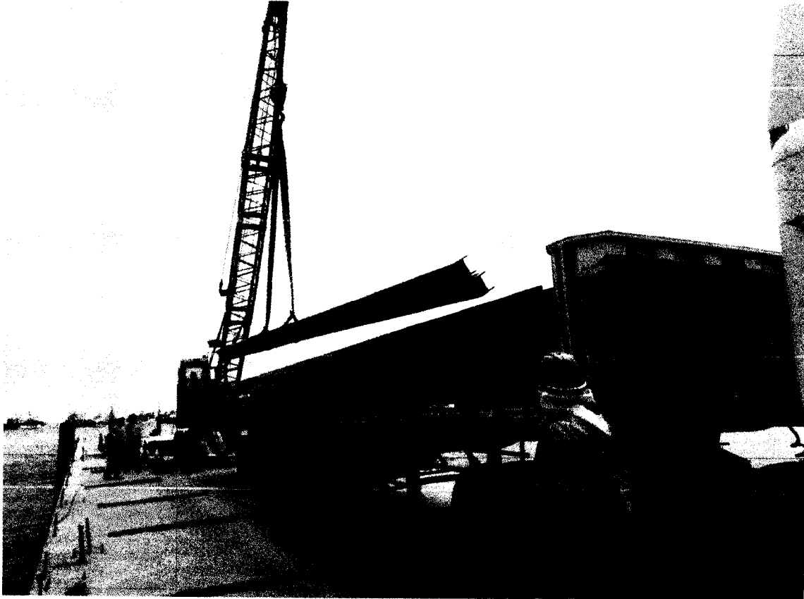
Foto N° 01: Transporte de Parantes metalicos tipo H al muelle (cabezo)
